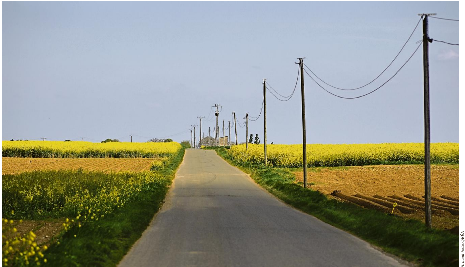
Une petite moitié des câbles de fibre optique en France ne sont pas enfouis dans le sol mais sont installés sur les poteaux de téléphonie ou d'électricité.
